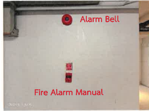
กริ่งสัญญาณเตือนภัย (Alarm Bell) และเครื่องแจ้งเหตุ โดยใช้มือดึง (Fire Alarm Manual Station)
