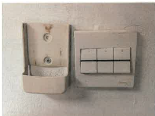
สวิตช์ควบคุมอุปกรณ์ไฟฟ้าแสงสว่าง แบบแยก ตัว
